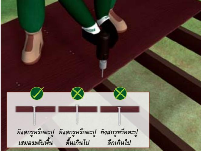
ยึดไม้พื้นเมอว่าเข้ากับโครงสร้างตงไม้ ด้วยสกรูเมอว่า Fix-T 1 $\frac{1}{4}$ " ซึ่งเป็นสกรูเกลียวปลายแหลมชนิดหัวผัง โดยยิงสกรูยึดทั้งสองด้าน ของไม้พื้นเมอว่าเข้ากับโครงสร้างตงไม้ทุกๆโครงติดต่อตามความยาวของแผ่นไม้
